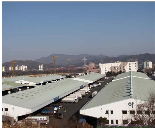
물류터미널 - 조립식 패널조
