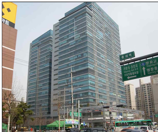
아파트형 공장 - 철골(철골철근)콘크리트조
