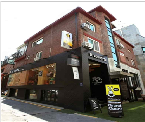
외국인관광 도시민박(게스트하우스) - 철근콘크리트조
