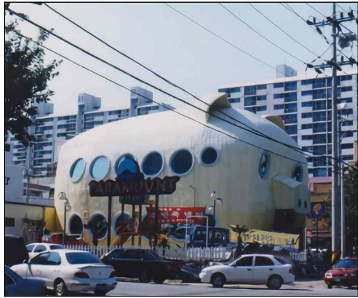
제1종 근린생활시설 - 와이어패널조
