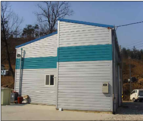
제1종 근린생활시설 - 철골조 중 조립식패널조
