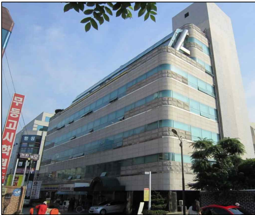
학원 등 - 철골(철골철근)콘크리트조
