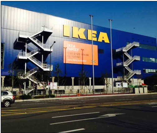
전문점 - 프리캐스트 콘크리트조
