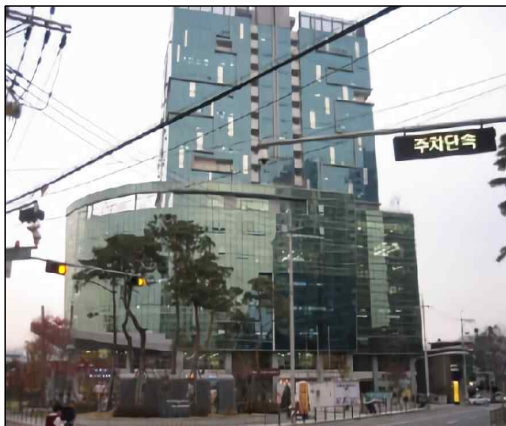
아파트형 공장 - 철골(철골철근)콘크리트조
