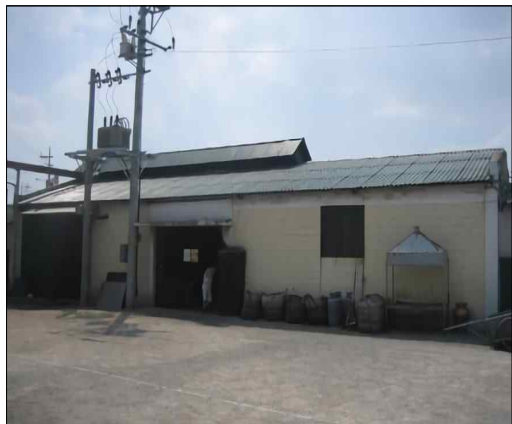
동식물관련시설(이외 축사) - 시멘트블록조
