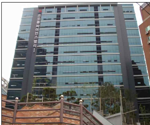
아파트형 공장 - 철근콘크리트조
