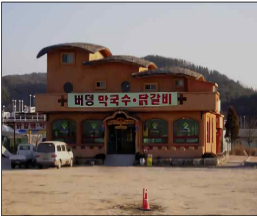
제2종 근린생활시설 - 와이어패널조
