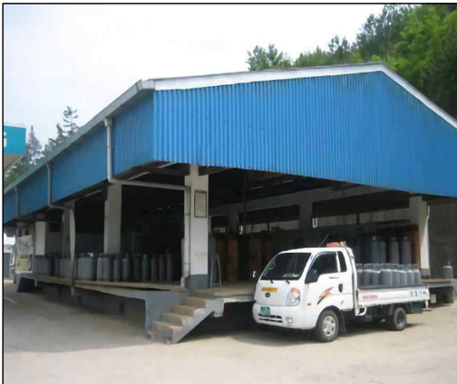
주유소, 충전소, 저장소 - 경량철골조
