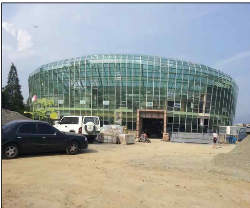
동물원, 식물원 - 철근콘크리트조
