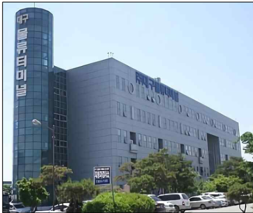
물류 터미널 - 조립식 패널조
