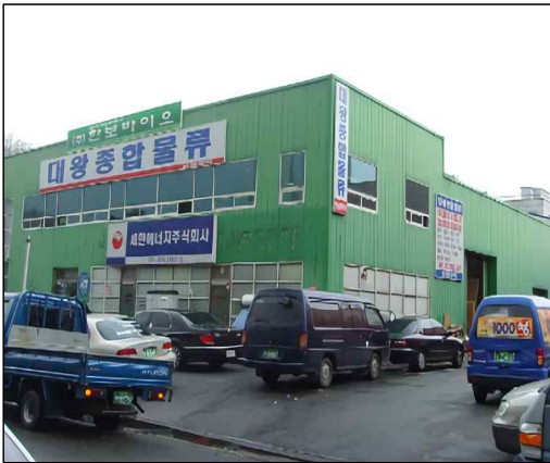
기타판매 및 영업시설 - 철골조
