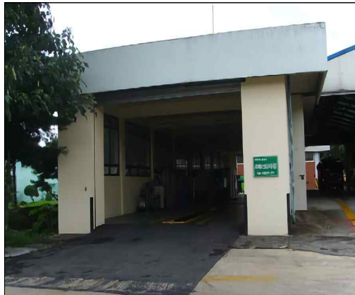
정비공장, 카센터 - 철근콘크리트조
