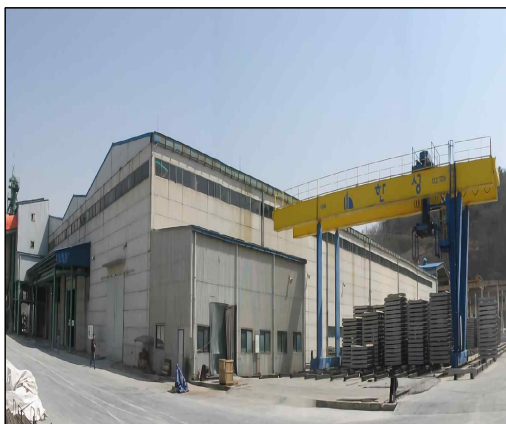
일반공장 - 프리캐스트 콘크리트조
