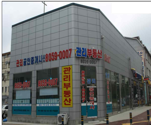
제2종 근린생활시설 - 철골조 중 조립식패널조(메탈판넬)
