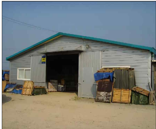
동식물관련시설(이외 축사) - 철골조
