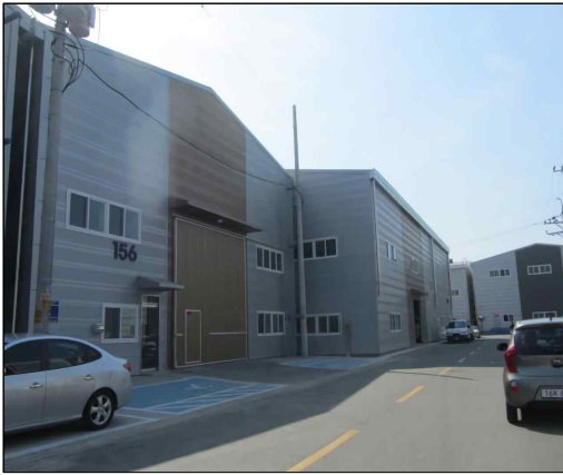
아파트형 공장 - 철골조
