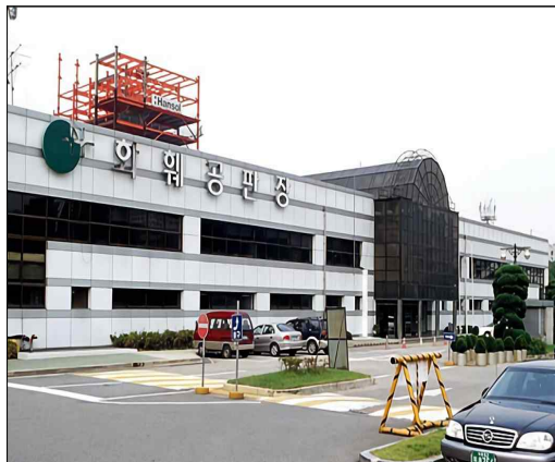
농수축화훼공판장, 경매장 - 철근콘크리트조
