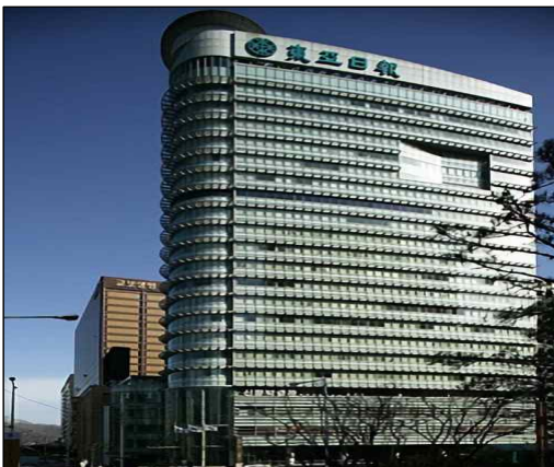
사무소, 신문사 - 철골(철골철근)콘크리트조
