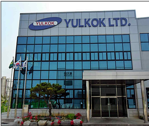
사무소, 신문사 - 철골조 중 조립식패널조(메탈판넬)
